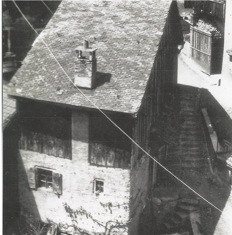
Fig. 15 La calade comporte 14 escaliers qui permettent d'accéder à la buanderie
