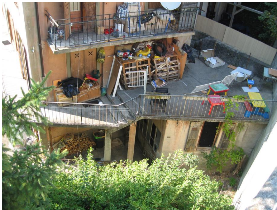
Fig. 13 L'atelier en 2007 après démolition du bûcher
