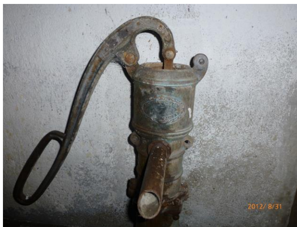
Fig. 15 La pompe à eau « Audemar Guyon » de la buanderie
