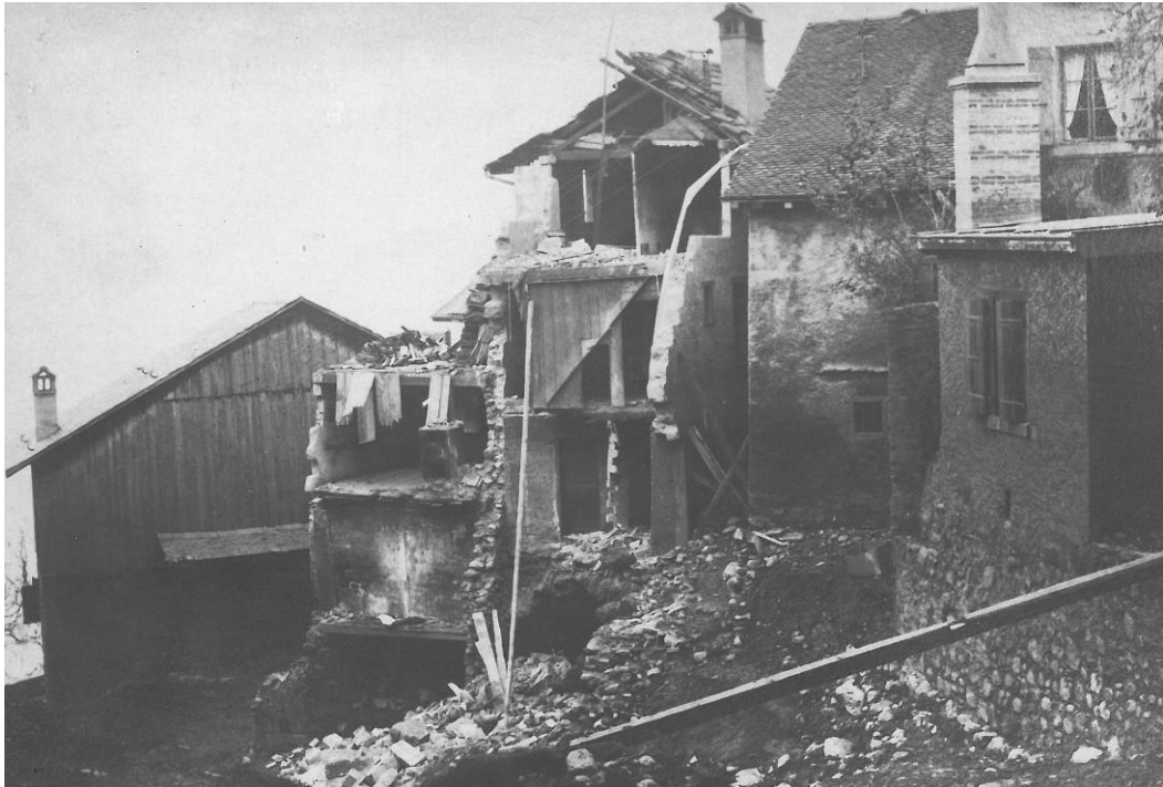
Fig.9 Restes de grange de Louis Martin et de la maison d'Henri et Susanne Pilet-Depallens 16
