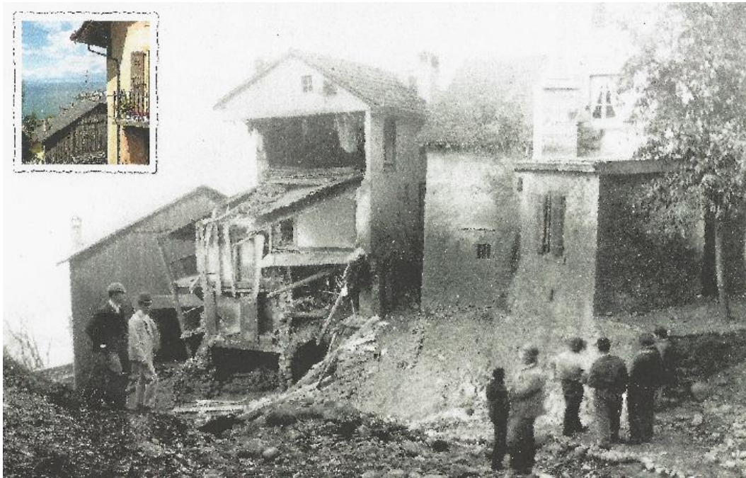
Fig. 8 Restes de grange de Louis Martin et de la maison d'Henri et Susanne Pilet-Depallens, arrachée par l'eau suite à la rupture du réservoir de Sonzier le 6 novembre 1888 15
